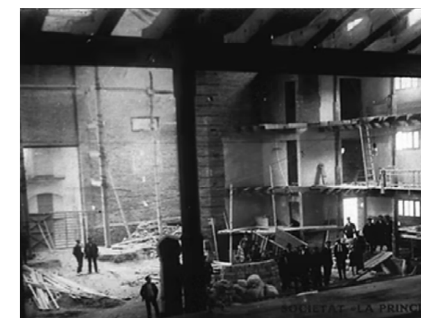
Teatre del Casal Societat La Principal durant la seva construcció (1921). Font: Arxiu d'imatges de La Principal
