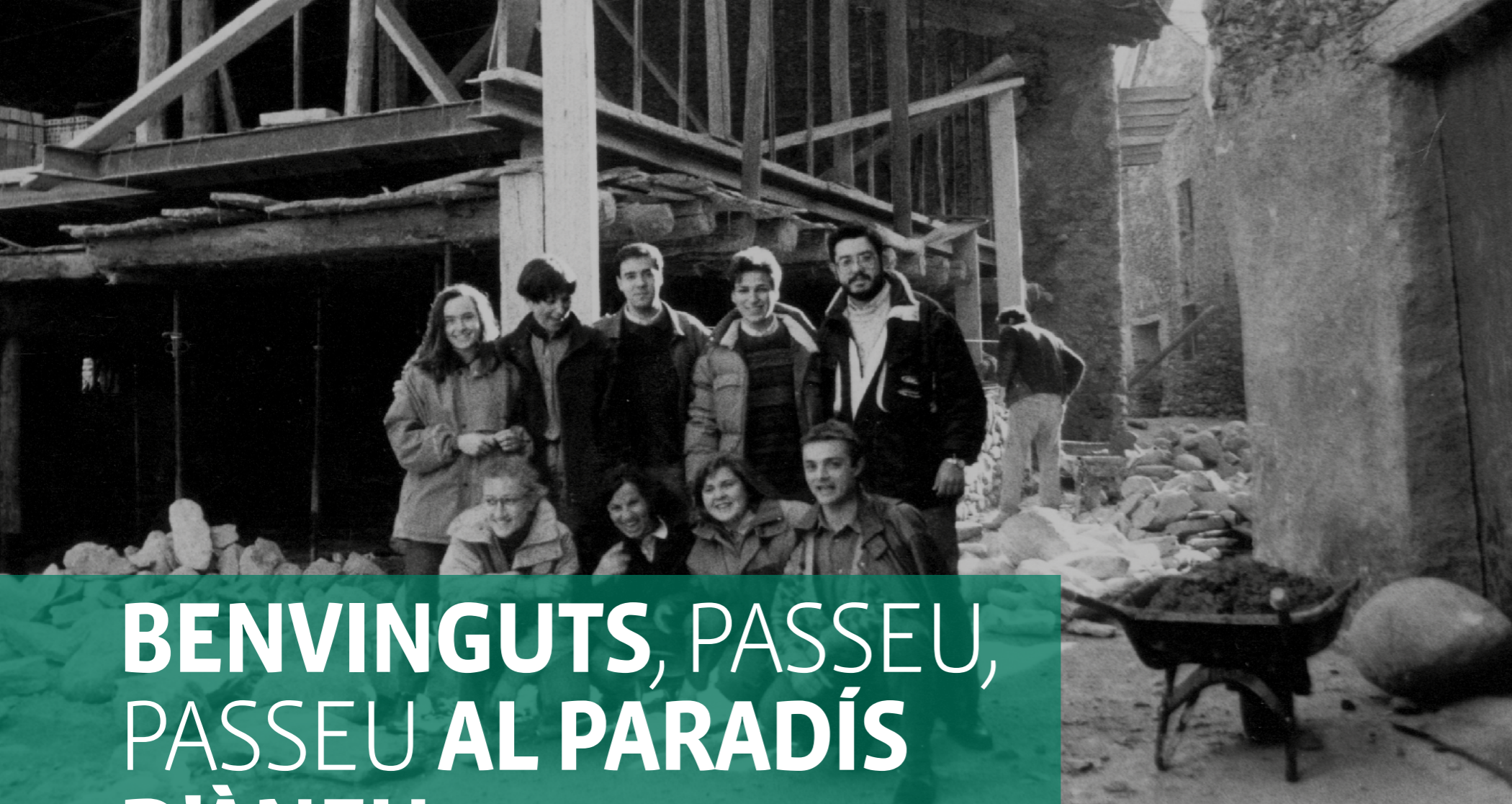
Imatge de la Casa Gassia, seu actual de l'Ecomuseu de les Valls d'Àneu, amb l'equip impulsor del projecte. (Estèrri d'Àneu, 1987). Arxiu d'imatges Joan Blanco del CCVÀ
