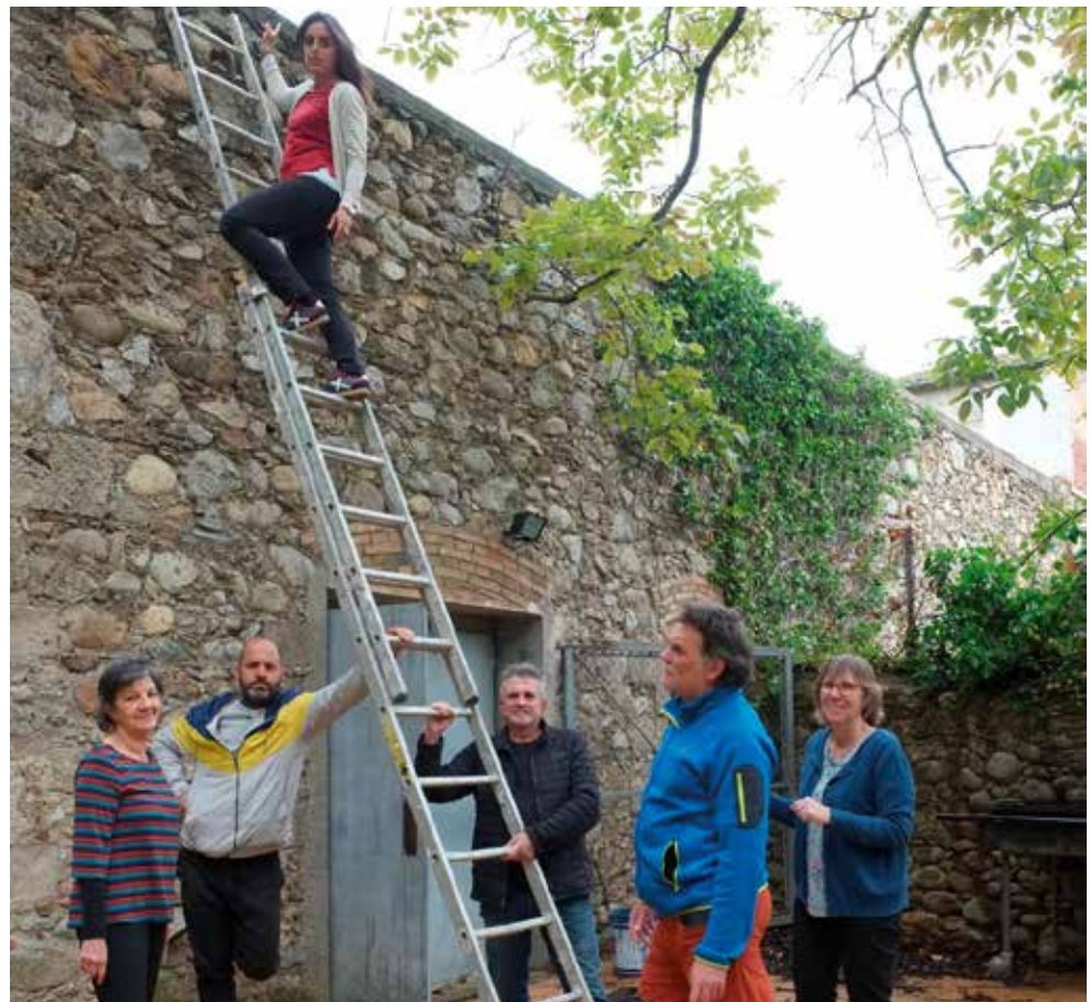
Socis de la Unió Escaulenca arreglant desperfectes de la façana.
